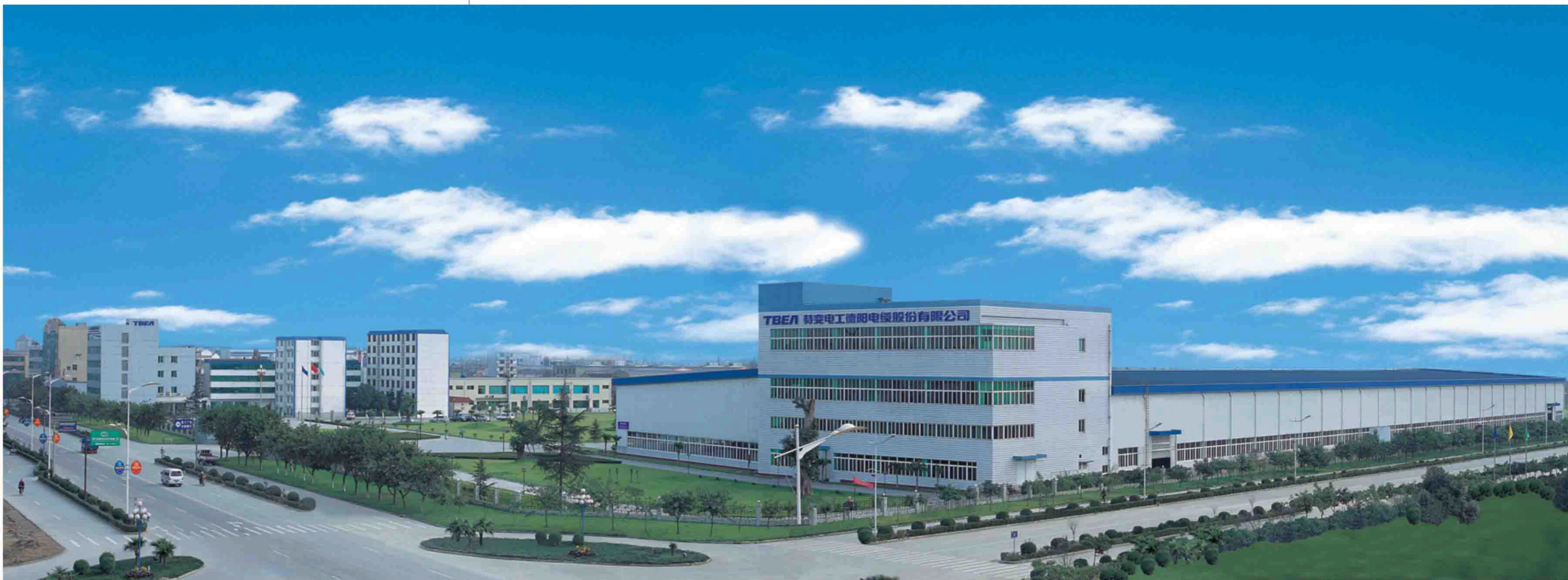
特变电工德阳电缆股份有限公司
